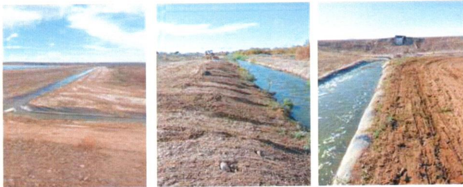
Arreglo de cruces y de canal de fuga
