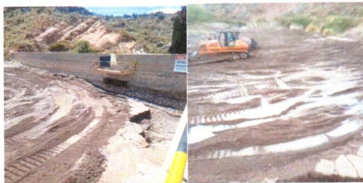
Ampliación y Profundización de Olla - Dique Toma.
