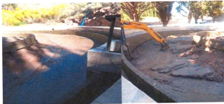
Limpieza de desarenador.
