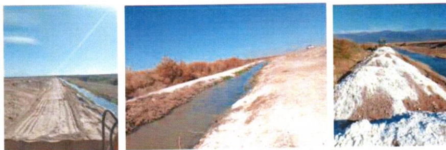
Elevación del terreno – Compactación con suelo cal
