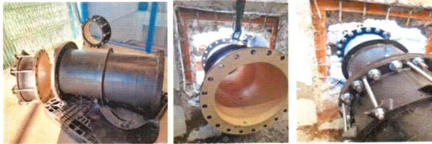
Colocación de carretel
