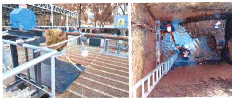
Placa disipadora Cámara de carga
