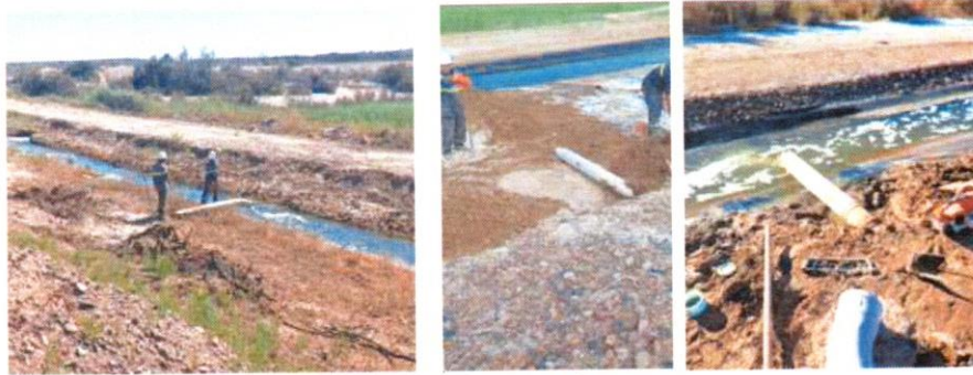
Trabajos en reemplazo de cruces
