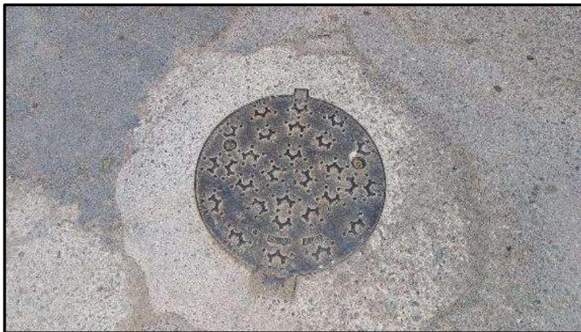
Ilustración 2: Boca de registro de la red cloacal existente
