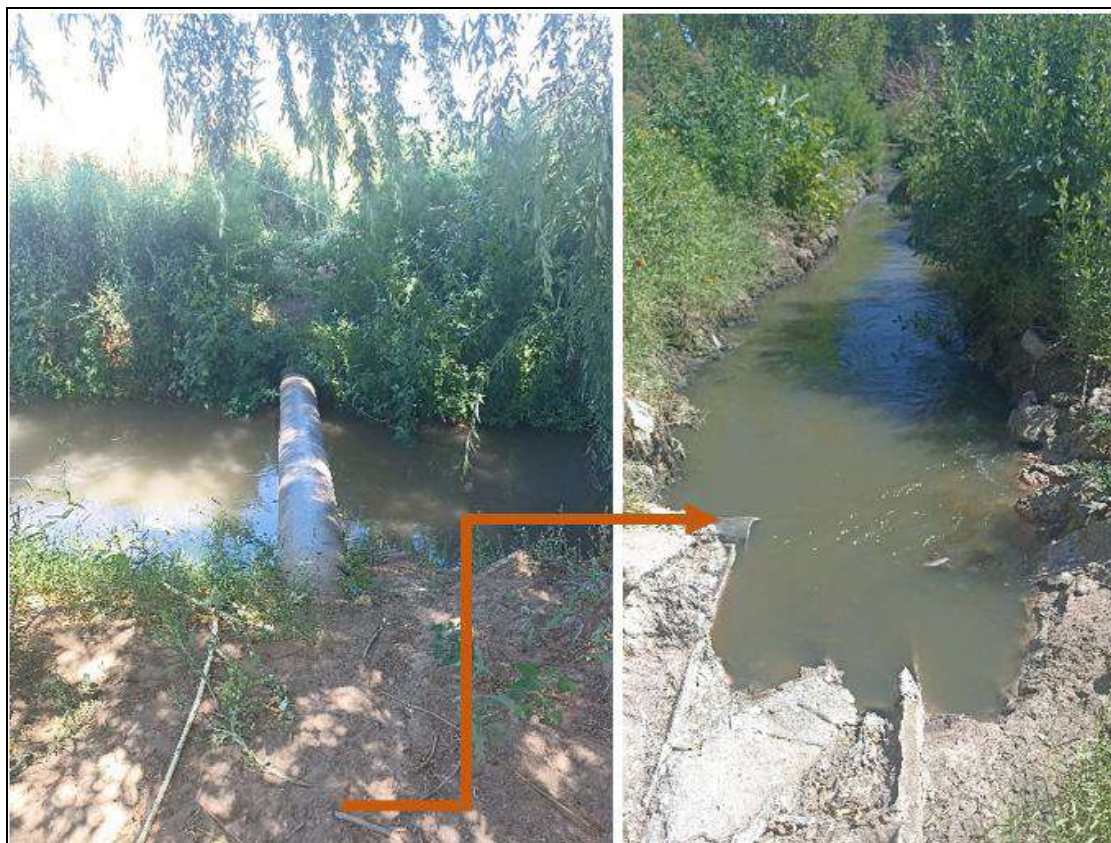
Ilustración 7: Colector cloacal N° 1 al canal de vuelco
