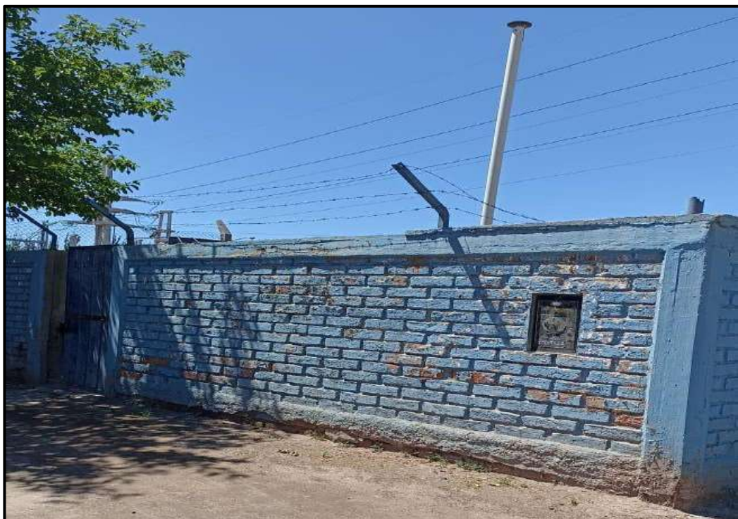
Ilustración 3: Recinto donde se localiza la estación elevadora existente
