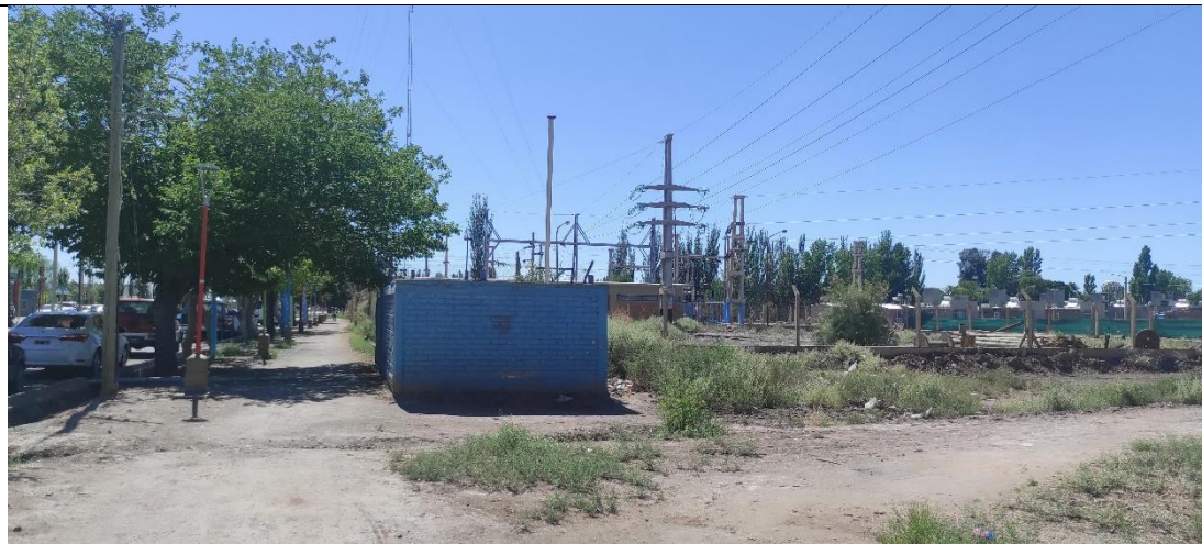
Inicio Proyecto. Estación de bombeo
