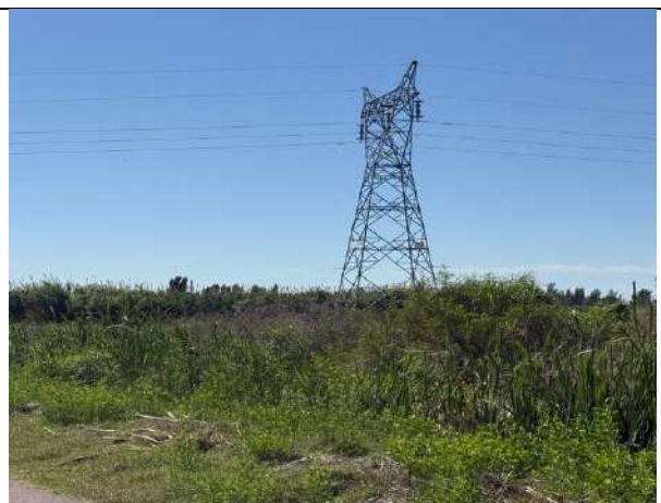
FOTO 14- Vista línea de tensión
