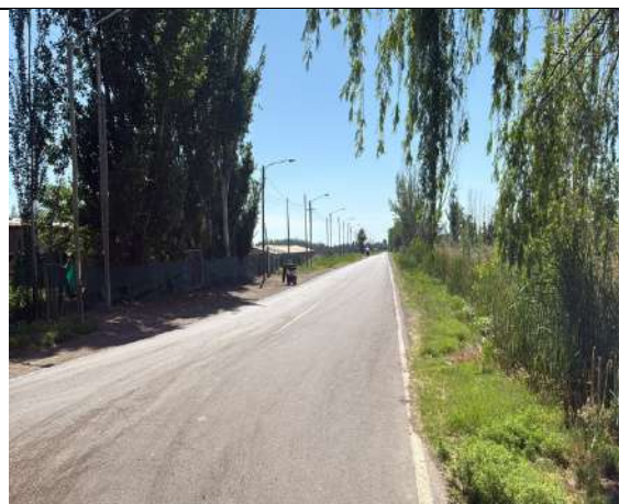
FOTO 6- Vista estado del asfalto de calle Mariani
