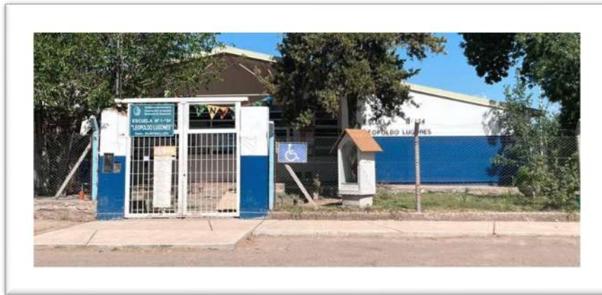
Escuela Leopoldo Lugones -calles Buenos Vecinos y Buena Nueva. COLECTOR PARAMILLO II (ETAPA II). Fuente: propia
