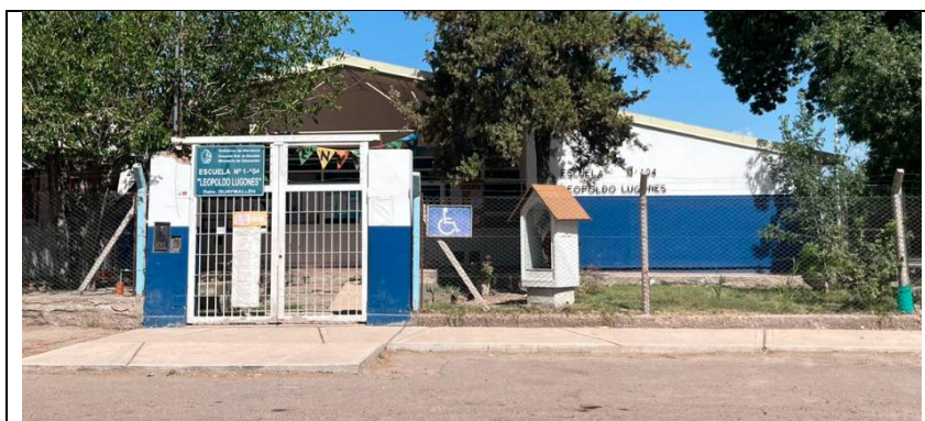
Escuela Leopoldo Lugones -calles Buenos Vecinos y Buena Nueva. COLECTOR PARAMILLO II (ETAPA II). Fuente: propia
