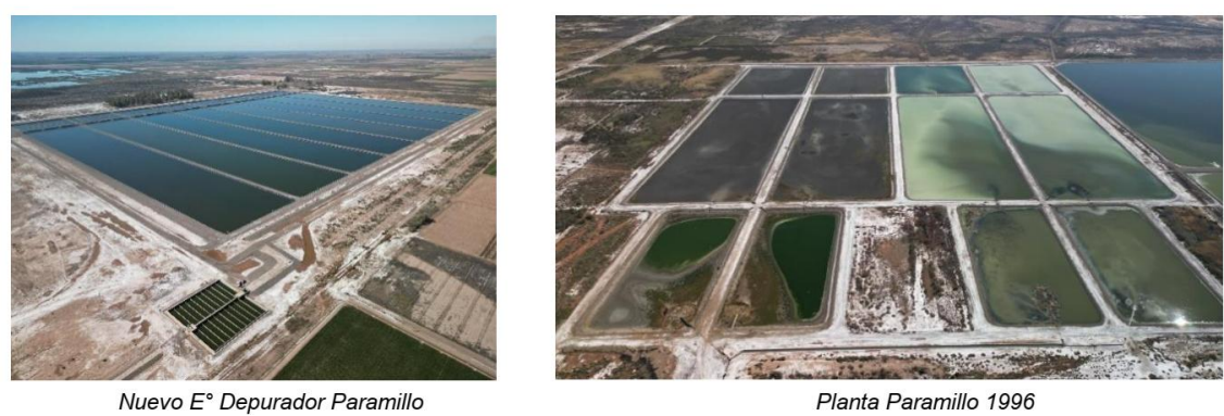
Figura 13: Instalaciones del tratamiento de efluentes
