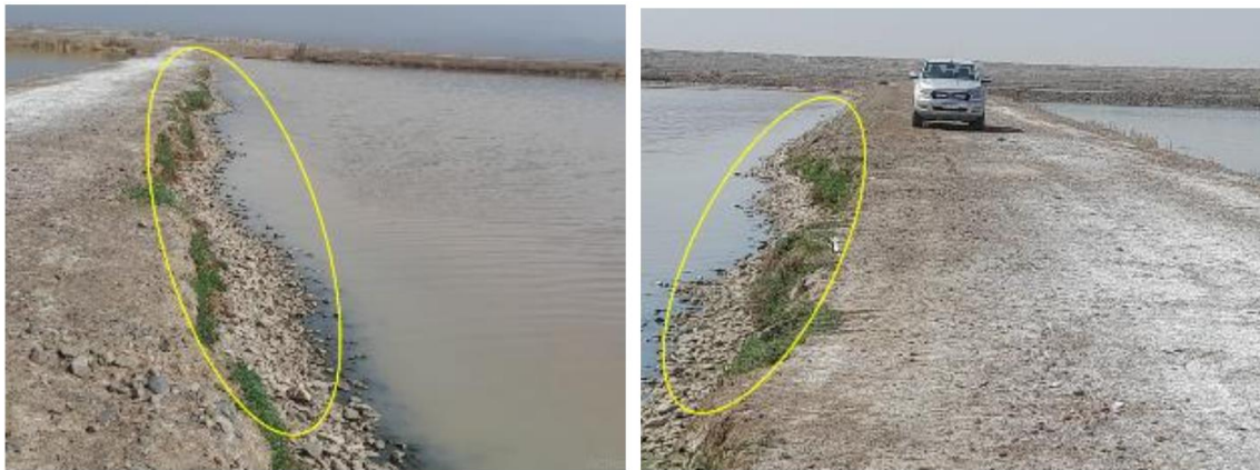
Figura 6: Vista de taludes a reparar
