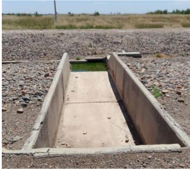
Figura 18: canal de salida
