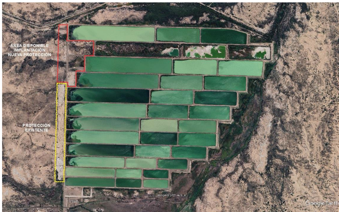
Figura 10: Vista de la defensa existente y sitio a intervenir con nueva defensa
