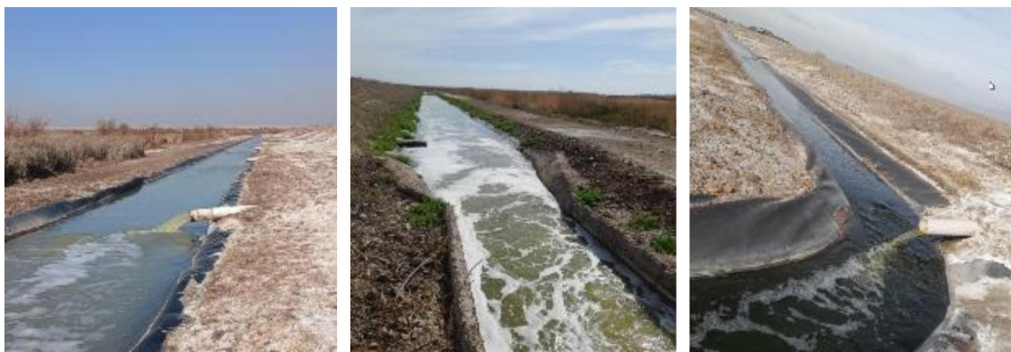
Figura 9: Conducciones salidas de Lagunas Terciarias a Canal de Fuga
